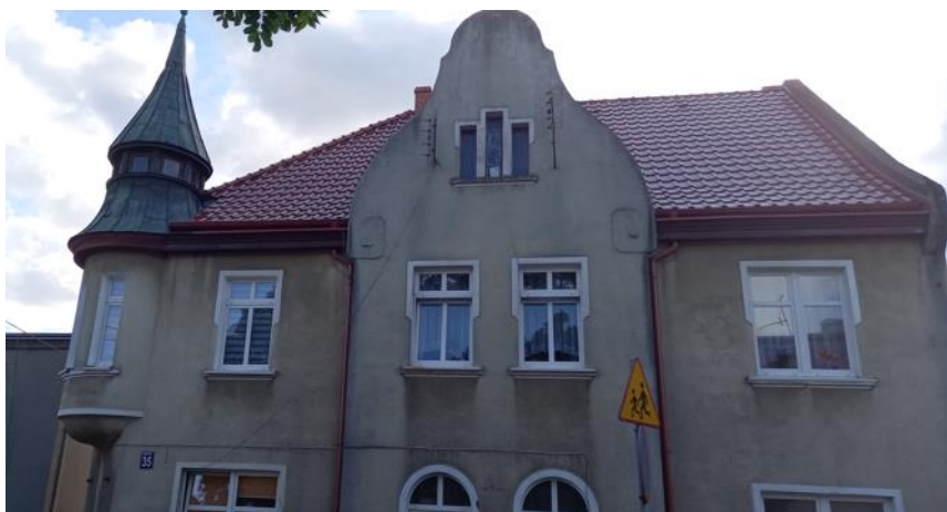
Zdjęcie pogładowe (elewacja frontowa)
