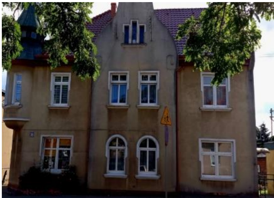
Zdjęcie pogładowe (elewacja frontowa)
