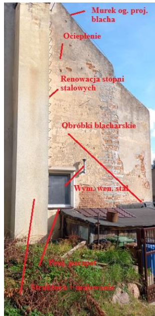
Zdjęcie poglądowe (elewacja szczytowa)
