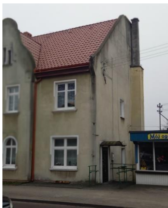
Zdjęcie poglądowe (elewacja szczytowa)
