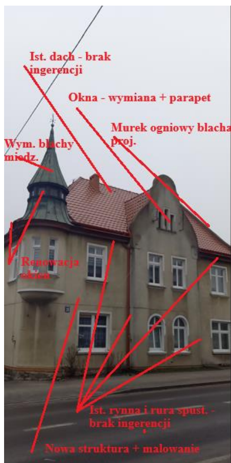
Zdjęcie pogładowe (elewacja frontowa)
