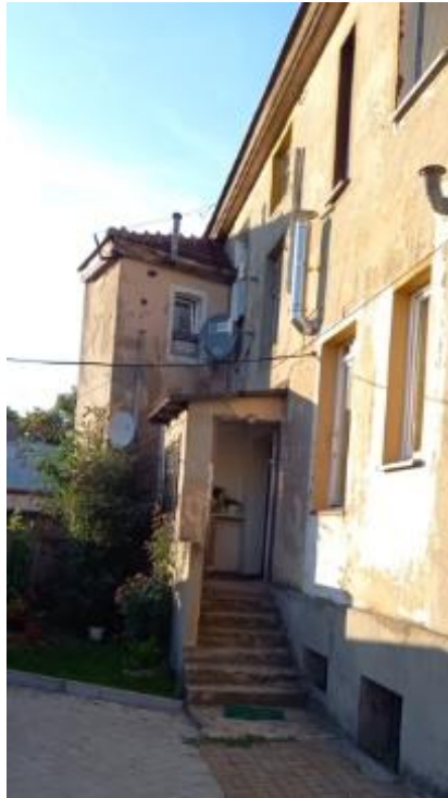
Zdjęcie pogładowe (elewacja południowa)
