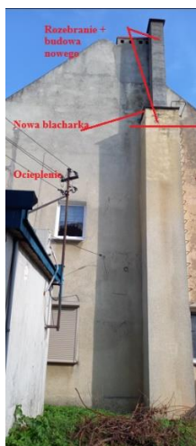
Zdjęcie poglądowe (elewacja szczytowa)
