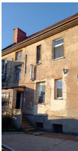
Zdjęcie poglądowe (elewacja południowa)
