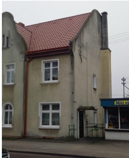
Zdjęcie poglądowe (elewacja szczytowa)
